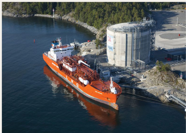
AGA Nynäshamn LNG marine terminal
