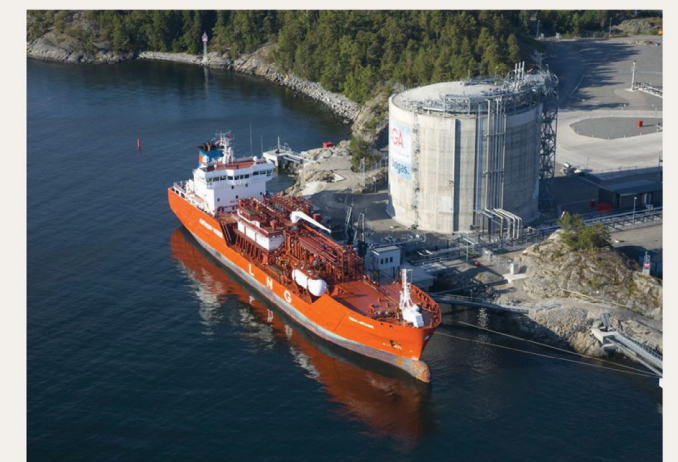
AGA Nynäshamn LNG marine terminal
